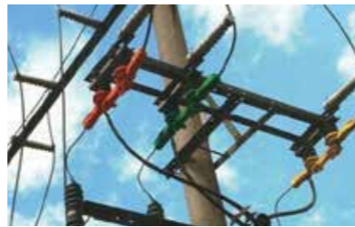
在变电线路中隔离刀闸的防护效果
